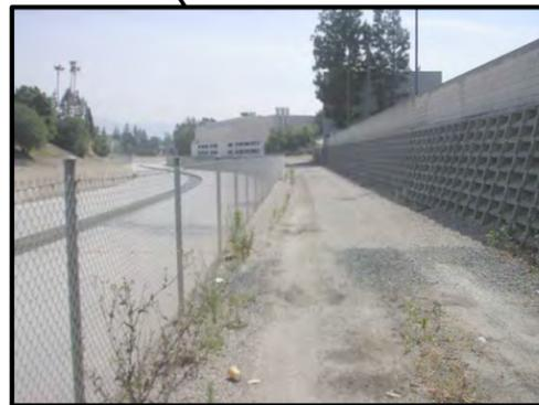
EXISTING UNIMPROVED DIRT MAINTENANCE ROAD WITH VEHICLE ACCESS. EXISTING CHAIN-LINK FENCE ALONG CHANNEL WALL.
